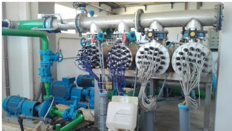
Fotografía 5 Sistema de desinfección con luz ultravioleta.
