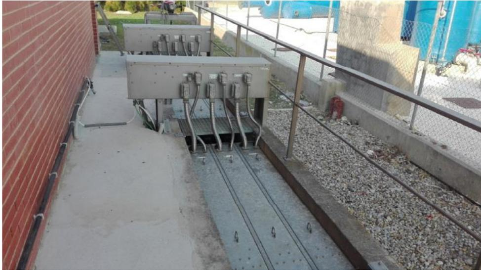
*Fotografía 2 Sistema de desinfección con luz ultravioleta.*
