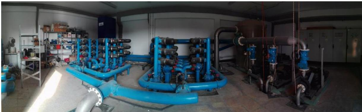
*Fotografía 1 Equipo de filtración de anillas.*
