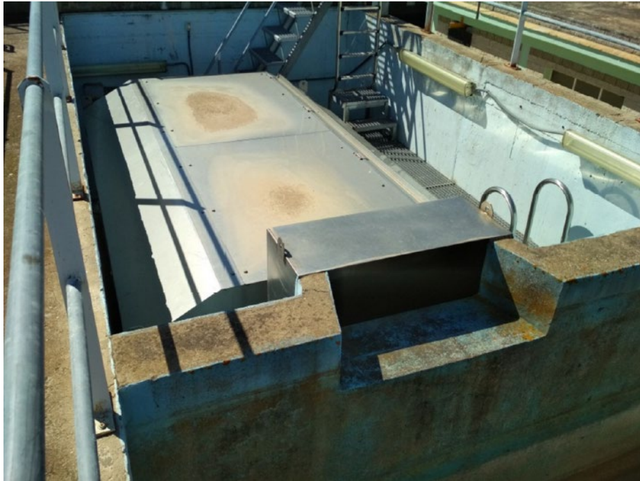
Fotografía 4 Microtamiz rotatorio
