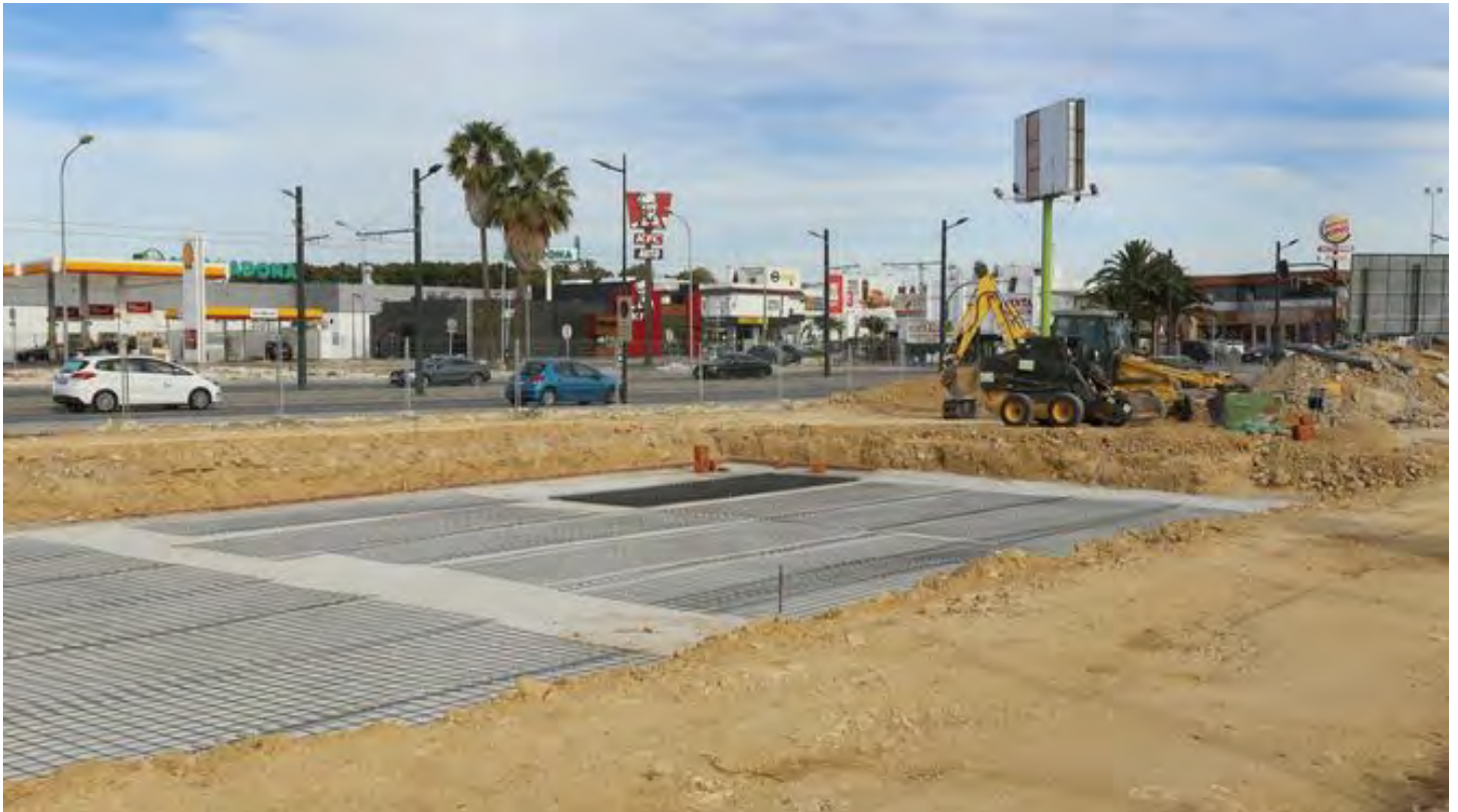
Trabajos de construcción del nuevo restaurante que se llevan a cabo actualmente en el polígono Urbisur. / SONIA RAMOS (Chiclana)
