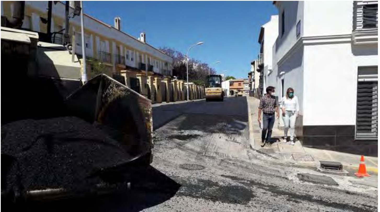
Trabajos de asfaltado realizados recientemente en la urbanización Cerro del Águila. / D.C. (Chiclana)
